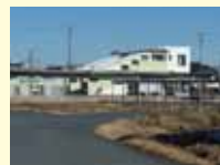
元加治駅南口整備
